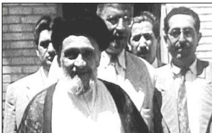
ابوالقاسم کاشانی و مظفر بقایی در خانه تخریب شده دکتر مصدق، ۲۹ مرداد ۱۳۳۲
