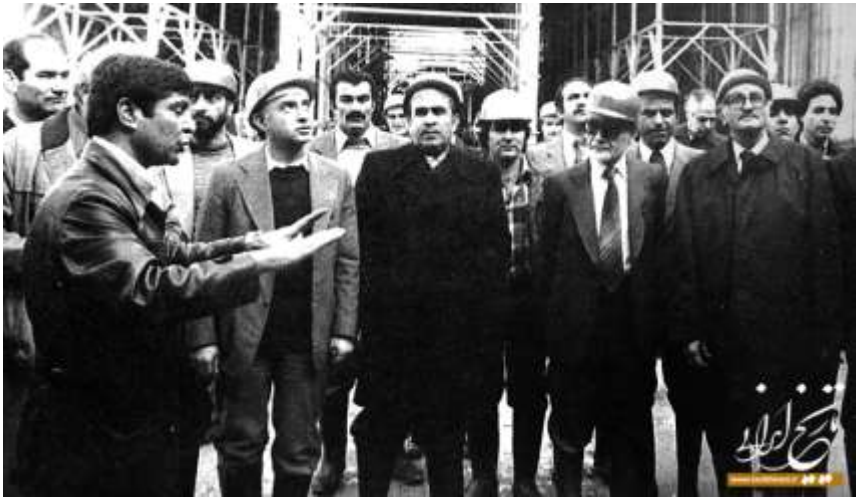
بازدید مهندس بازرگان، مهندس کتیرایی، مهندس سبحانی، مهندس ابراهیمی و مهندس توسلی از پروژه در حال ساخت مترو تهران (۱۳۵۹)
